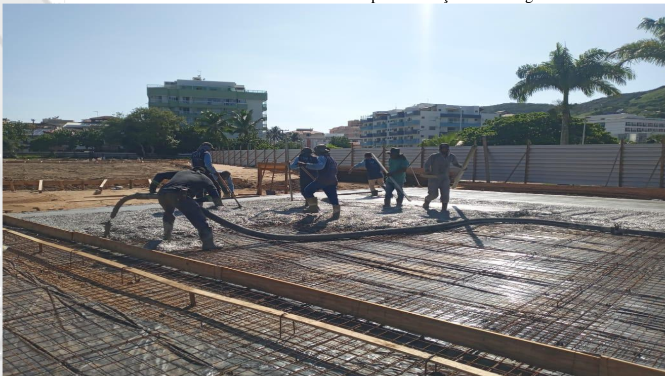
F 05- funcionários sem o uso de EPI's e uniforme na etapa de armação das ferragem.
