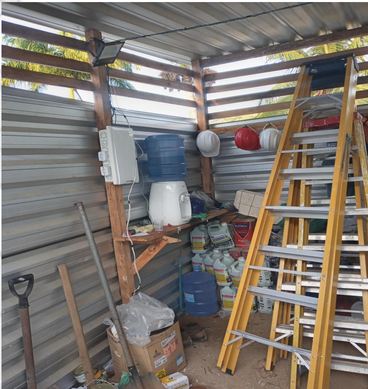
F 07- Instalações de bebedouro em local improprio, e não atende a demanda de funcionários ( reclamação por parte dos funcionários )
