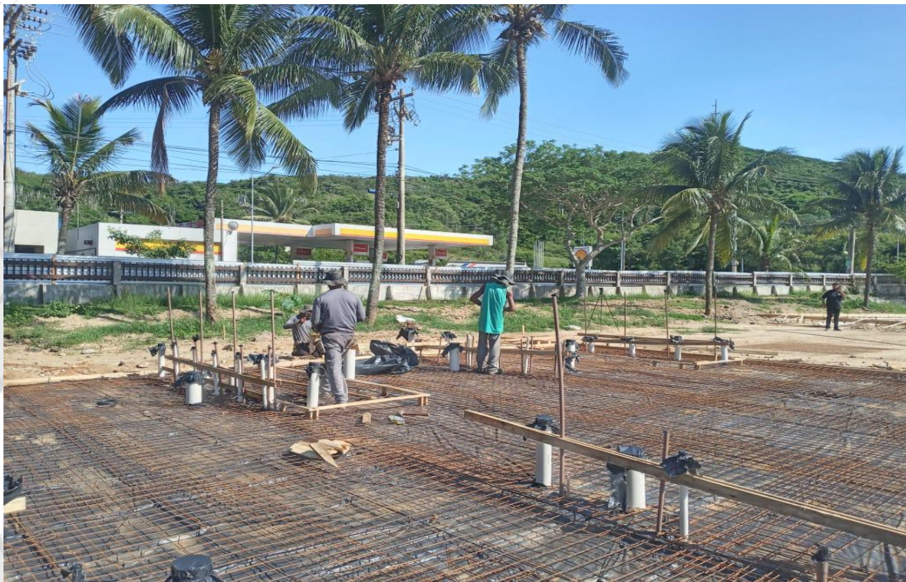
F 05- funcionários sem o uso de EPI's e uniforme na etapa de armação das ferragem.
