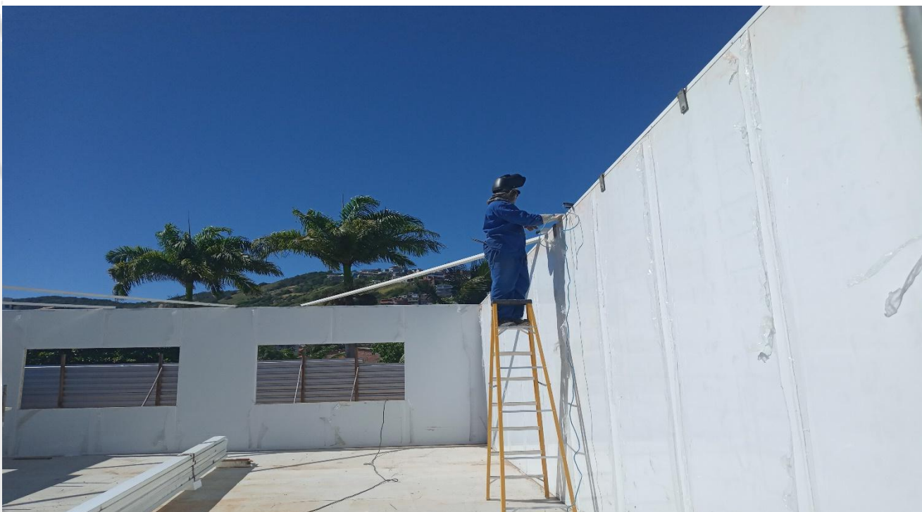
F 02- F 01- Funcionários sem o uso de EPI's, e equipamentos para trabalhando em altura . NR35
